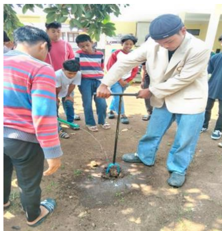
Gambar 5. Demonstrasi dan praktik pembuatan Lubang Resapan Biopori.
