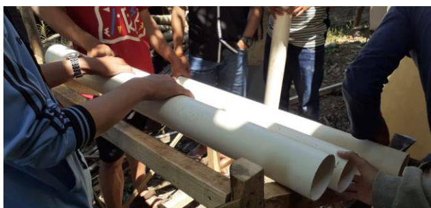
Gambar 2. Pembuatan Instalasi Hidroponik
